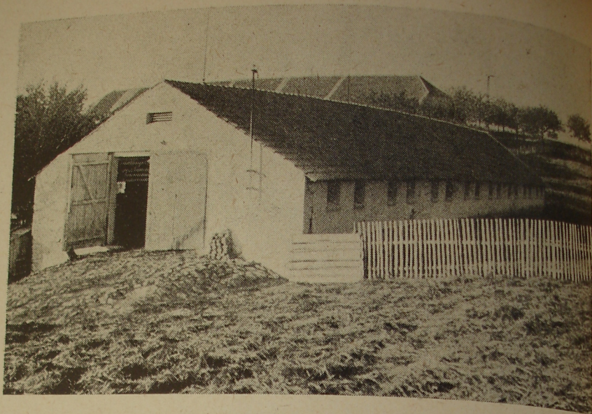
89. Nesprávně vybudovaný ovčín bez skladovacího prostoru, přípravy krmiv a pod. — Foto Ing. Keck.
