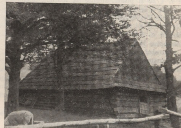
Obr. 1. Chlév pro zimní ustájení ovcí. Dříve „zimovisko“, dnes součást hoferského hospodářství, Brenna — foto Štika 1958.
